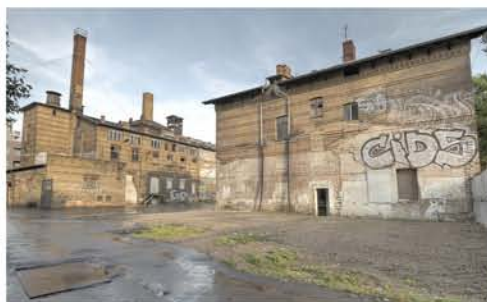
Eingang I mit Blick auf Haus 5, Zollhaus und Haus 3 . Kesselhaus. © Denny Müller
