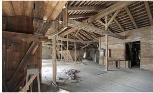
Haus 3a Kesselhaus, Dachgeschoß. © Denny Müller
