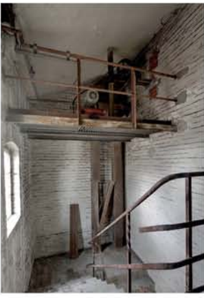
Haus 2, Treppenhaus mit Motor des Getreideförderbandes. © Denny Müller
