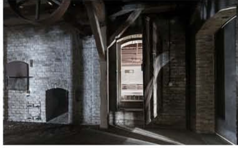
Haus 2, Blick auf den Darreneingang. © Denny Müller
