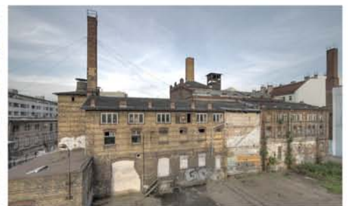
Haus 3a+b, Kesselhaus. © Denny Müller
