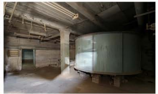
Haus 3b, Kesselhaus Anbau. © Denny Müller
