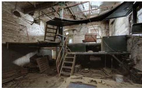
Haus 3a, Kesselhaus. © Denny Müller
